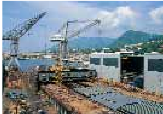
Il cantiere di Castellammare di Stabia Castellammare di Stabia shipyard
