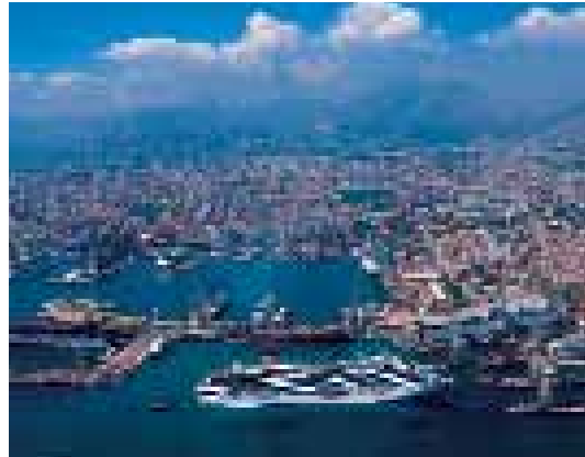
Il cantiere di Palermo Palermo shipyard
