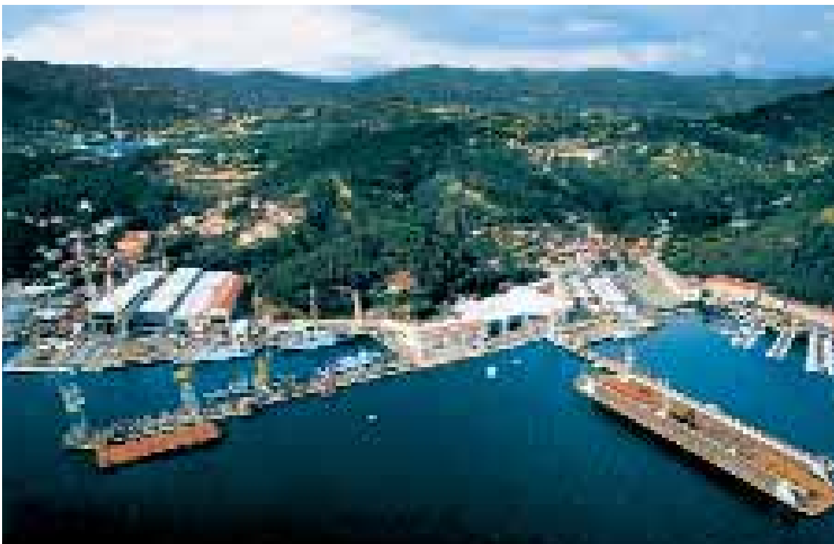
Il cantiere di Muggiano Muggiano shipyard
